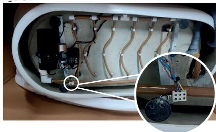
**A** - Faça a ligação elétrica da banheira ligando a alimentação e o terra no conector de porcelana, que fica sob a banheira próximo aos pés conforme figura 1.
